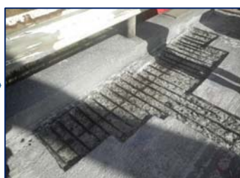
床版の傷んだ部分を取り除く
