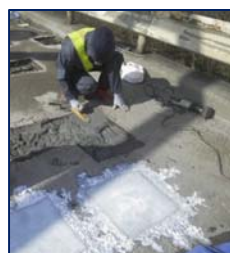
樹脂モルタル補修
