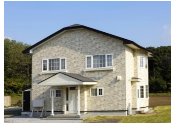
リフォーム前：築年数が経ち、外壁のサイディングが傷んでいる。リフォーム後：レンガ調の金属サイディングのカバー工法で美しく仕上がった事例。
